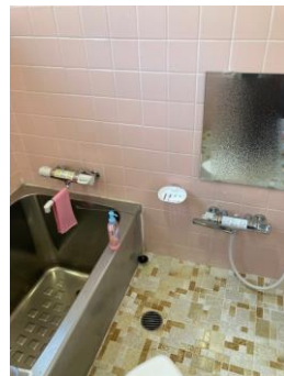
床・壁がタイル貼り
