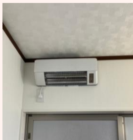
脱衣室のヒーター
